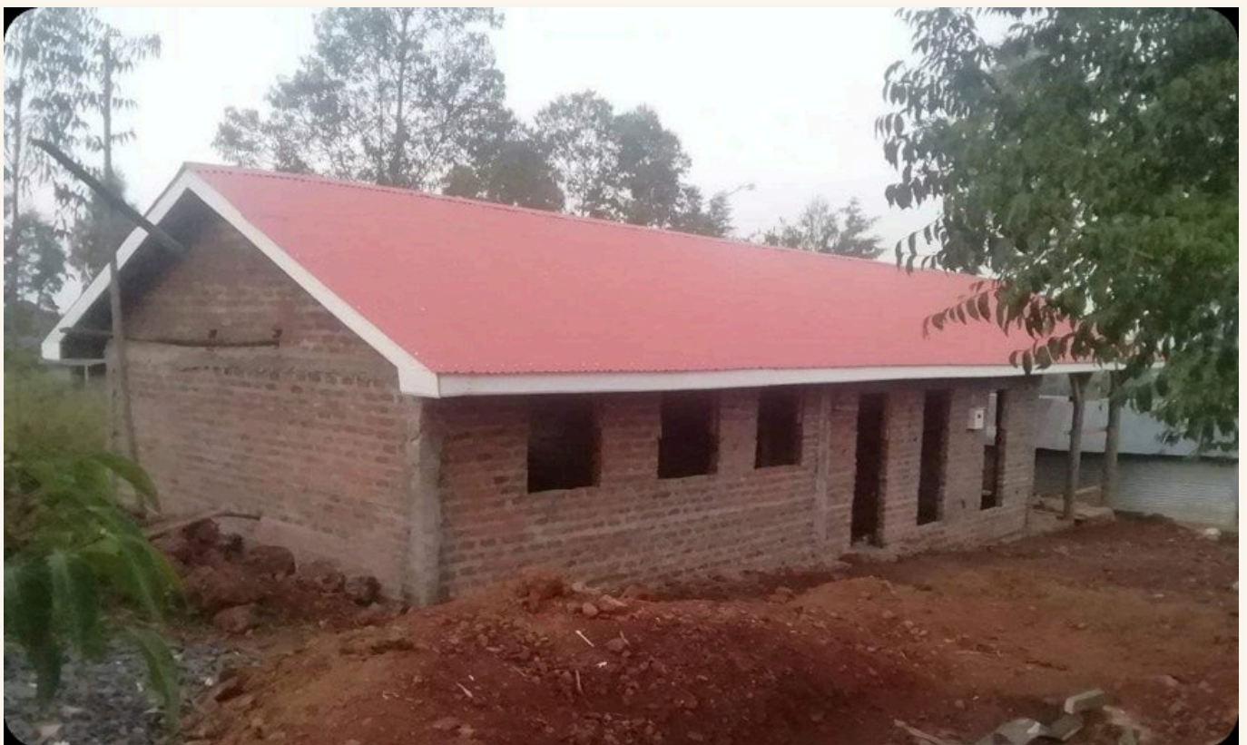
Nová budova základní školy ve výstavbě — dokončena v roce 2022.
